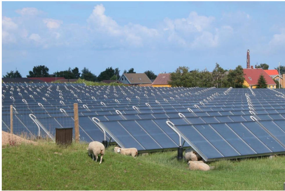
Abb. 50: Beispiel Solarthermie-Freifläche
