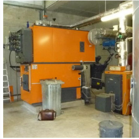
Abb. 36: Holz-Hackschnitzelkessel
